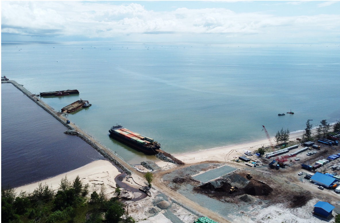
Gambar 30. Proyek-Proyek Pembangunan Pelabuhan Kawasan Industri
